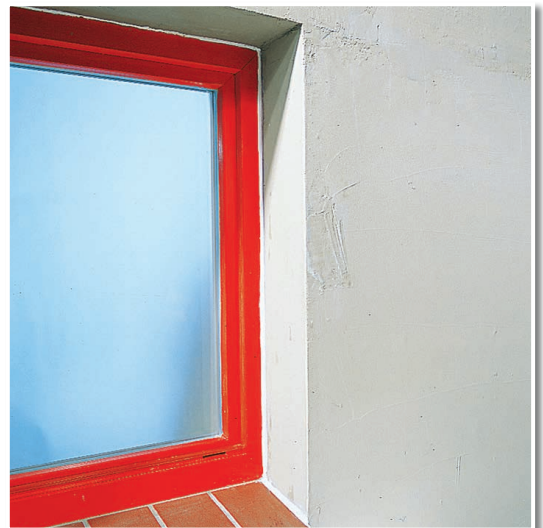
Verschluss der Anschlussfugen zwischen Fenster und Mauerwerk.
